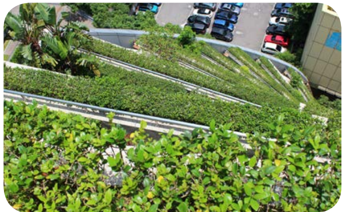
大樓植栽區的噴灌系統依天候調控用水
